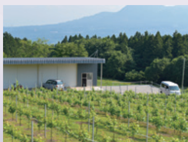
駐車場の整備
